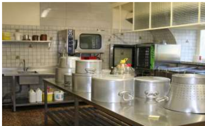
Réfection du plafond de la cuisine du château
