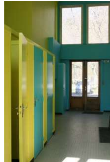
Réfection des vestiaires du gymnase
